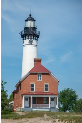
Au Sable Lighthouse
